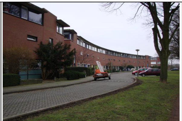
Nieuwbouw aan de Jachthoornstraat
